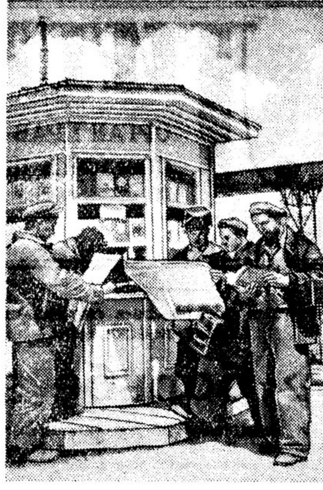
У kiosка Союзпечати в котловане на строительстве Сталинградской гидроэлектростанции. Фото М. Редькина
